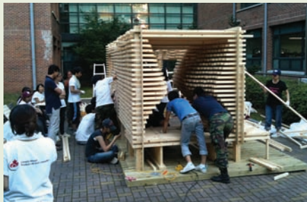
S-P-F 규격재와 판재를 이용한 목재 파빌리온
