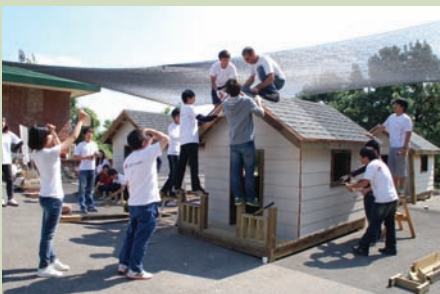
골조 완성 후 지붕 마감 작업
