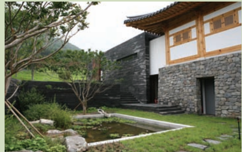
한식목구조로 지어진 재실과 경골목구조로 지어진 안채가 서로 연결되는 부분
